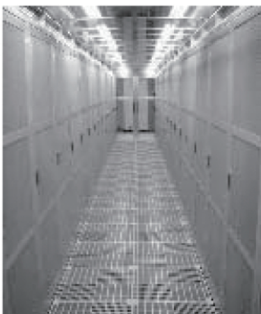
新宿データセンターに設置したブレードサーバ対応ラック
